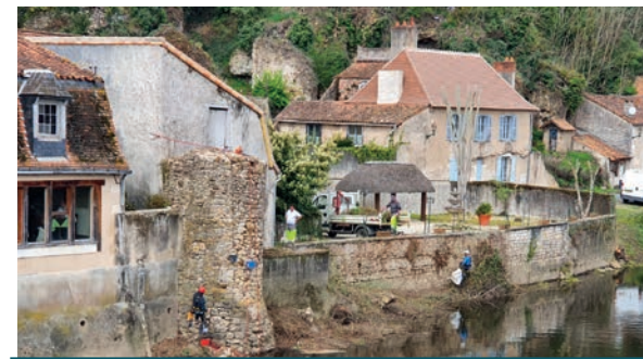
Cordistes à l'œuvre pour le nettoyage de la tour moyenâgeuse de la ville (vue du Vieux Pont)
