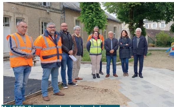
Mai 2022. Réception de chantier de la cour de l'école maternelle rue Jules Ferry
