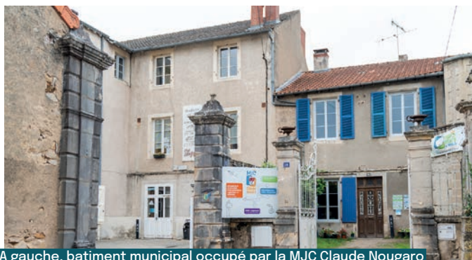
A gauche, bâtiment municipal occupé par la MJC Claude Nougaro qu'il convient de réhabiliter
