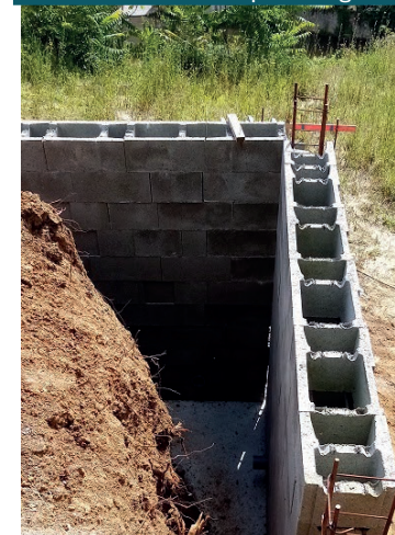
Réfection du mur situé place Régine Deforges
