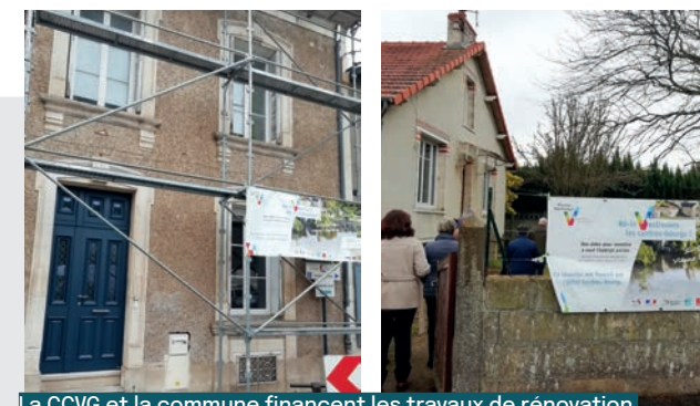
La CCVG et la commune financent les travaux de rénovation de maisons de propriétaires bailleurs ou occupants
